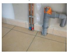
Obturer à l'aide d'un joint acrylique, d'un ciment fin ou d'une mousse de polyuréthane selon le cas.
