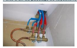
Obturer à l'aide d'un joint acrylique, d'une mousse de polyuréthane ou d'un enduit selon l'orifice à colmater.
