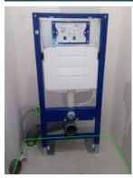
L'étanchéité à l'air doit être traitée en amont de la pose de l'habillage du WC suspendu, au niveau du pied de cloison, de l'évacuation des eaux usées et de l'arrivée d'eau.
