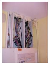
L'air arrive par le haut et par le bas du tableau, au passage des alimentations et des départs dans le plafond et le plancher
