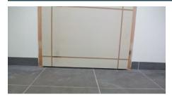
Vérifier la planéité de la porte, la bonne mise en place du joint périphérique et du joint balais, le réglage des pênes et de leurs gâches respectives.
