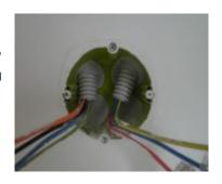
Fuite d'air au niveau du tableau électrique (dans la mesure où celui-ci est placé dans le volume chauffé)
