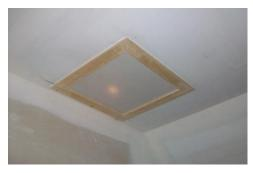
Vérifier la bonne mise en place du joint et la planéité de la trappe. Pensez à placer un isolant sur le dessus de la trappe afin de lester celle-ci pour que le joint soit parfaitement écrasé.
