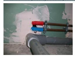
Obturer à l'aide d'un joint acrylique, mousse PU, plâtre selon orifice à colmater.
