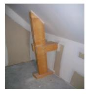
Appliquer un joint acrylique au passage des éléments dans les cloisons et entre les différents éléments.
