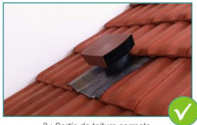
2 : Sortie de toiture correcte
