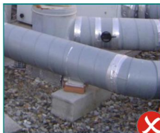
3 : Conduit rigide horizontal avec support NON adapté
