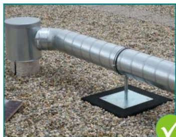
2 : Conduit rigide horizontal correctement supporté
